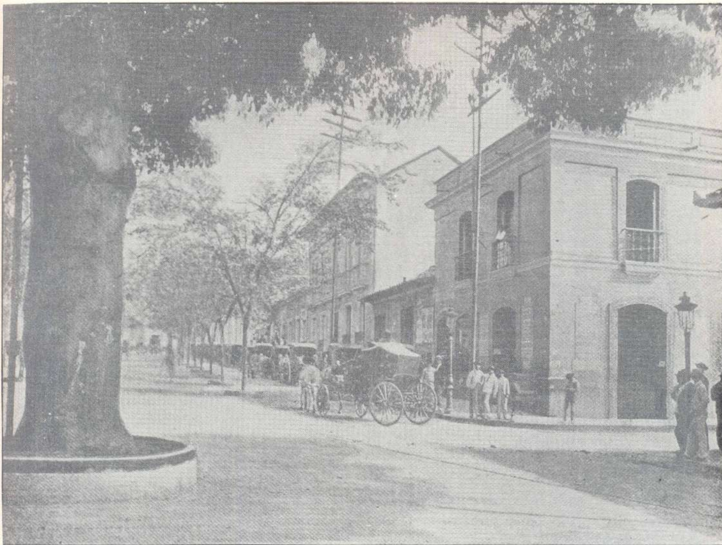
CARACAS—CALLE SUR 2—ESQUINA DE SAN FRANCISCO
